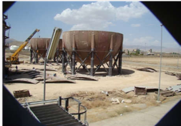
مخازن کروی برای ذخیره‌سازی سیال تحت فشار پالایشگاه اراک
